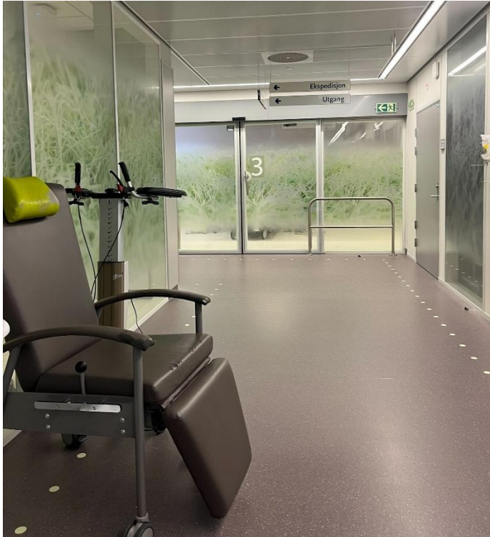
Figur 63 Eksempel på frosting av vegger og dører inn til pasientrom i korttidsposten, Haukeland universitetssjukehus HF. Foto: Sykehusbygg HF
