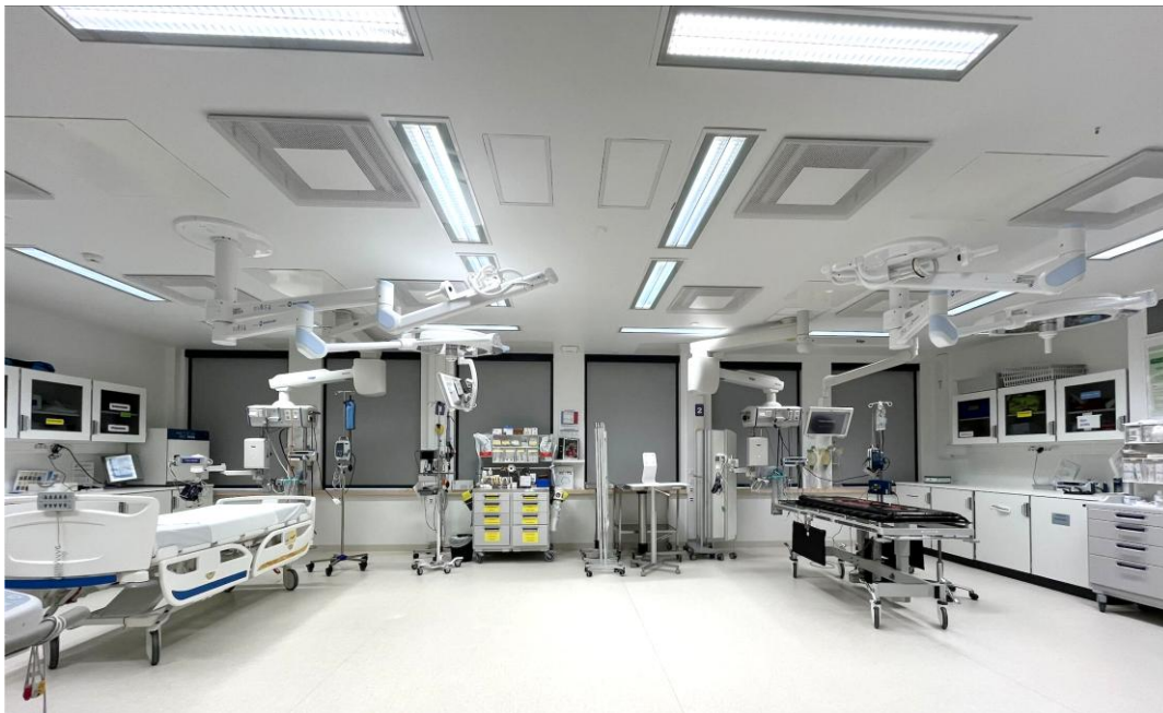
Figur 28 Traumerom med plass til 2 pasienter. akuttmottaket Nordlandssykehuset Bodø. Foto: Sykehusbygg HF
