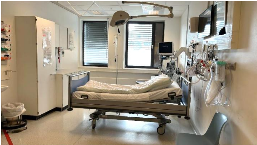
Figur 65 Barnerom ved akuttmottaket Bærum sykehus med videooverføring til barnelege ved Drammen sykehus, Vestre Viken HF. Foto: Sykehusbygg HF
