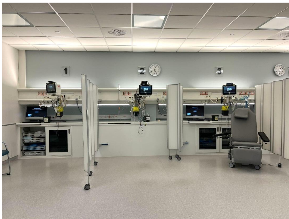
Figur 32 Utsnitt av triagesal på akuttmottaket, Haukeland universitetssjukehus HF. Foto: Sykehusbygg HF
