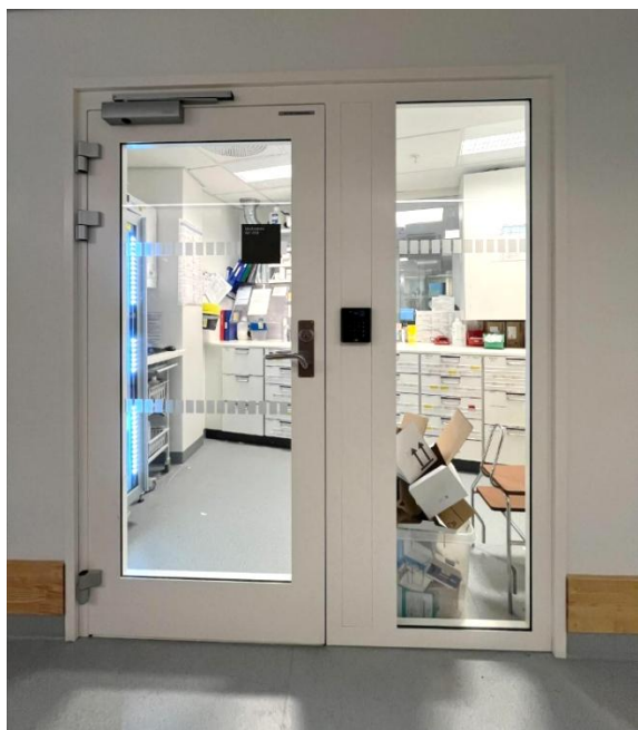
Figur 56 Medisinrom med vindu for sikkerhet, Nordlandssykehus Bodø HF. Foto: Sykehusbygg HF
