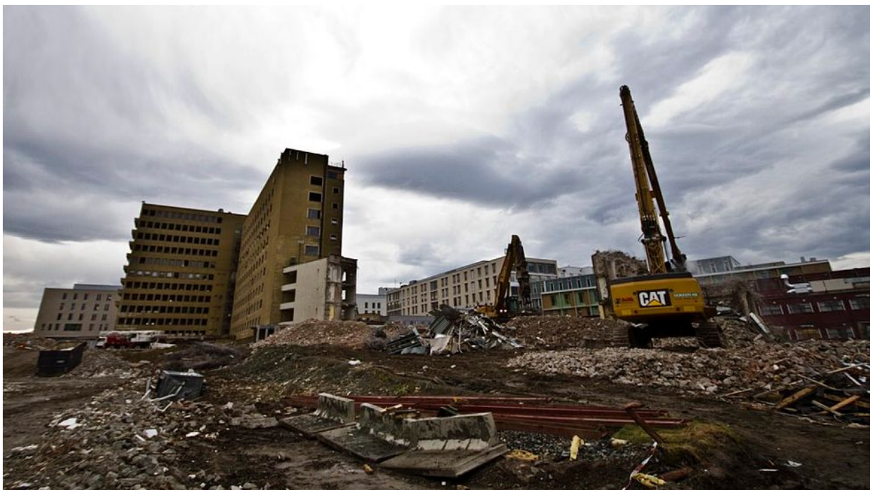
Figur 2: Riving av den gamle høyblokka St.Olavs hospital (Foto: Sykehusbygg HF)
