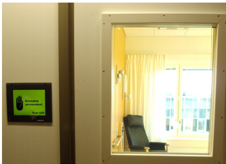
Figur 35 Vindu i dør inn til pasientrom, Västerås sjukhus, Sverige
