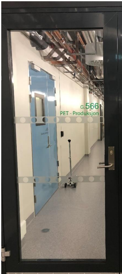
Figur 9.2 Inngang til PET-produksjon fra sør. (Kilde: Sykehusbygg HF)
