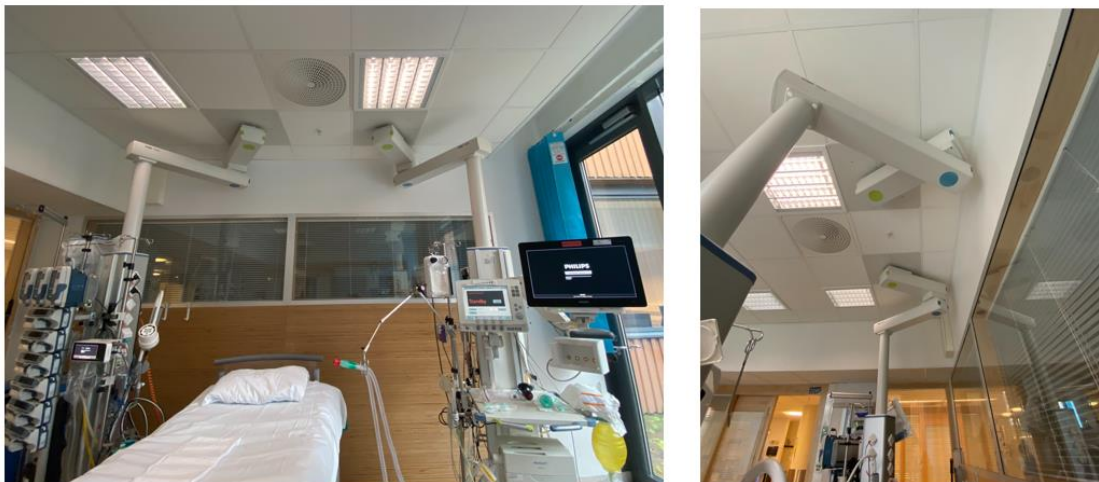
Figur 7.11 Intensiv St. Olavs hospital: Innfesting av taksøyer
