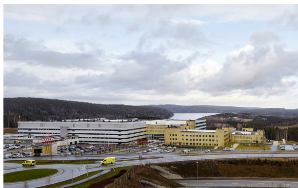
Psykiatribyggnaden i Kalnes är den guldkladda till höger, de somatiska specialiteterna finns i den blå byggnadsdelen till vänster om huvudentrén.
