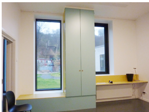
Enpatientrummen i Vejle har hög takhöjd vilket släpper in mycket dagsljus och minskar risken för manipulation av installationer i taket.
