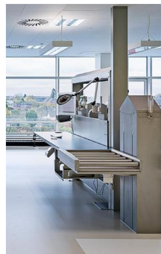
Bilde 22: Arbeidsbord, på Reginoal Sterilcentral Herlev, med rullebånd på kortsiden. Foto: Jørgen True (CF Møller, u.d.)
